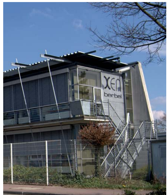
Проектно-испытательный центр berbel в г. Райне
